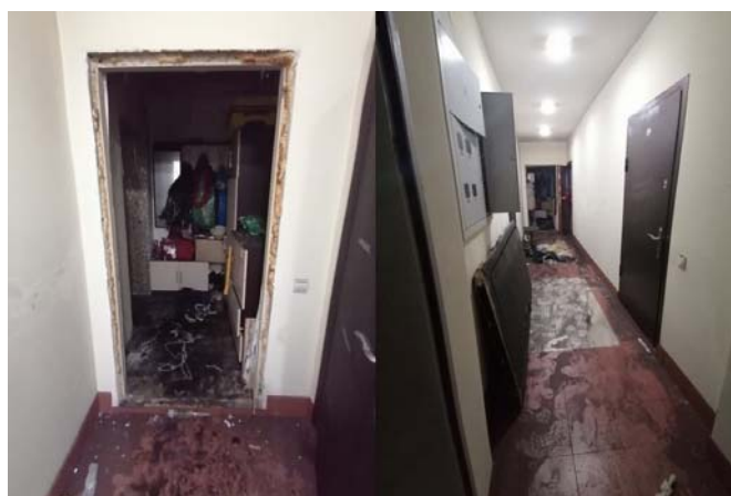
Рис. 2. Последствия взрыва аккумуляторной батареи электросамоката
