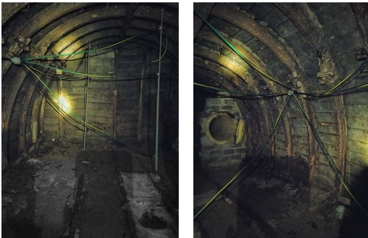
Рис. 8. Многоточечный пробоотборник УСДОП в условиях учебно-тренировочного полигона подземного типа (приемочные испытания)
