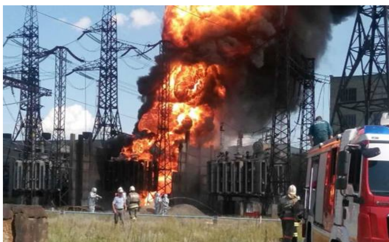
Рис. 4. Пример применения средств защиты пожарного (теплоотражательные костюмы), на пожаре 22 августа 2014 года на отдельно стоящей трансформаторной подстанции по улице Шкирятова Тракторозаводского района, Волгоградской области [3]
